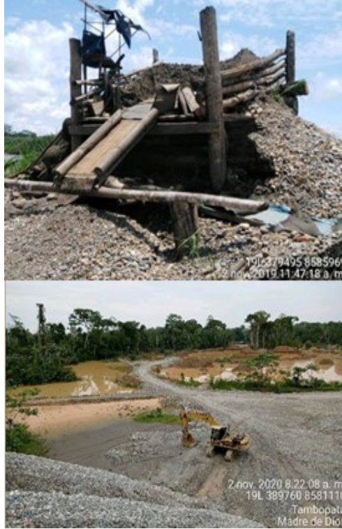
Figura 25: Vista de chute (arriba) y cargador frontal (abajo) en campo.
